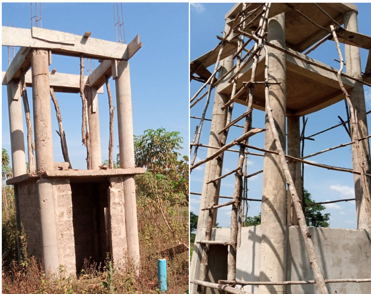
Planche 2 : Etat d'avancement des installations de système d'irrigation des sites de Tchaourou
