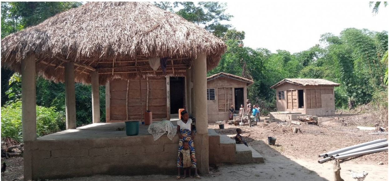
Photo 15 : Vue d'ensemble de la cuisine, du réfectoire et de deux éco lodges en construction-forêt de Gnanhouizounmè
